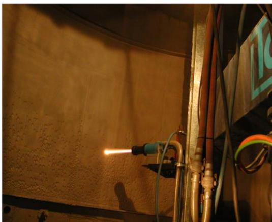
**Нанесение защитного покрытия на внутреннюю поверхность колонны**
